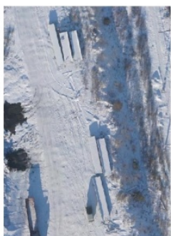
Рисунок 8.1. Складирование строительных материалов на ПК 8216 – ПК 8217
